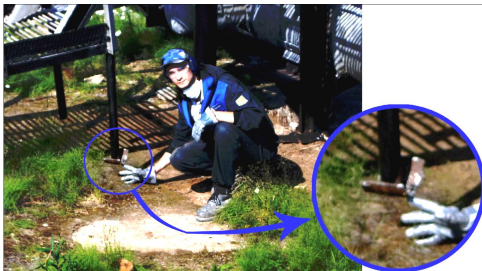
Рис. 1. Фотоизображение деформации малонагруженной обвязки ДКС, на одном из месторождений Крайнего Севера (Лапоухов А.Н., 28.07.2008 г.)
