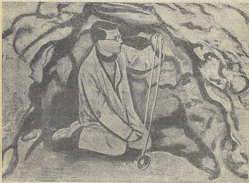
Рис. 11. Карстовая пещера в известняках на трассе метро.
