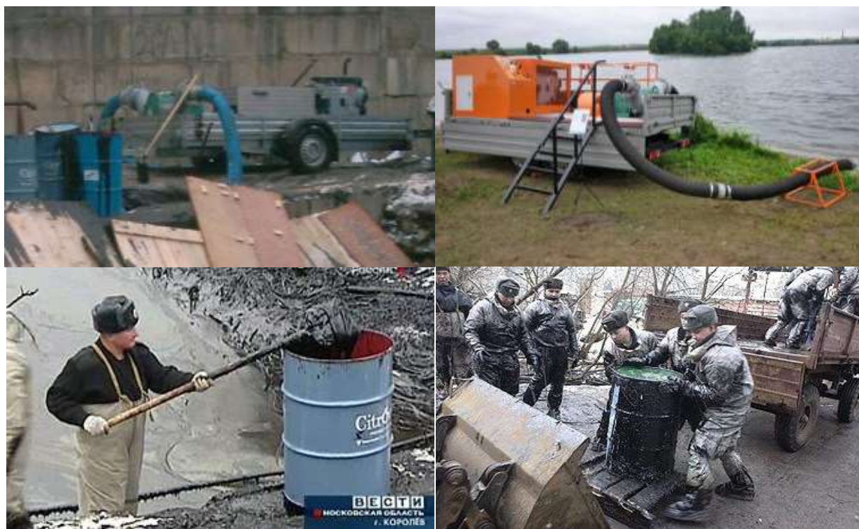
Рисунок 6.2.3 – Попытка применения пожарного насоса Netzsch Tornado XLB4-JD-60 при ликвидации разлива мазута в г. Королёв зимой 2008 г. была безуспешной (см. презентацию и видео).
