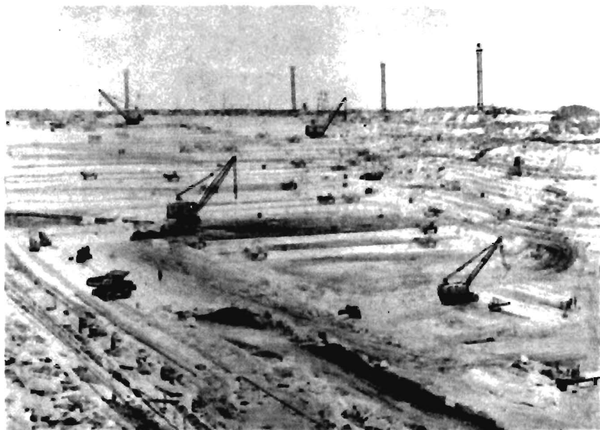
Рис. 71. Уступы для вырезки блоков на Коелгинском карьере мрамора
