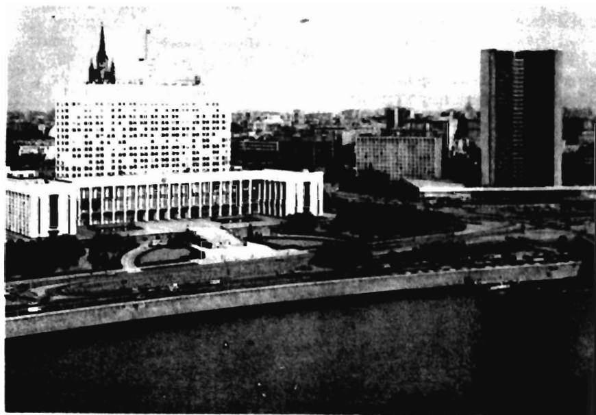
Рис. 89. Здание Совета Министров РСФСР. Архитектор Д.Н. Чечулин
