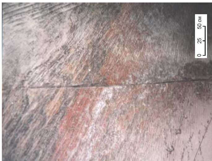
Рис. 4.17. Фрагменты трещин скола в пластах Б и Б-В. Панель 4, блок 2, западная стенка и кровля камеры № 167 в 107 м от устья (а) (фото В.А. Шабакина) и кровля камеры № 156 вблизи ее устья (б) (фото В.Е. Васюкова)
