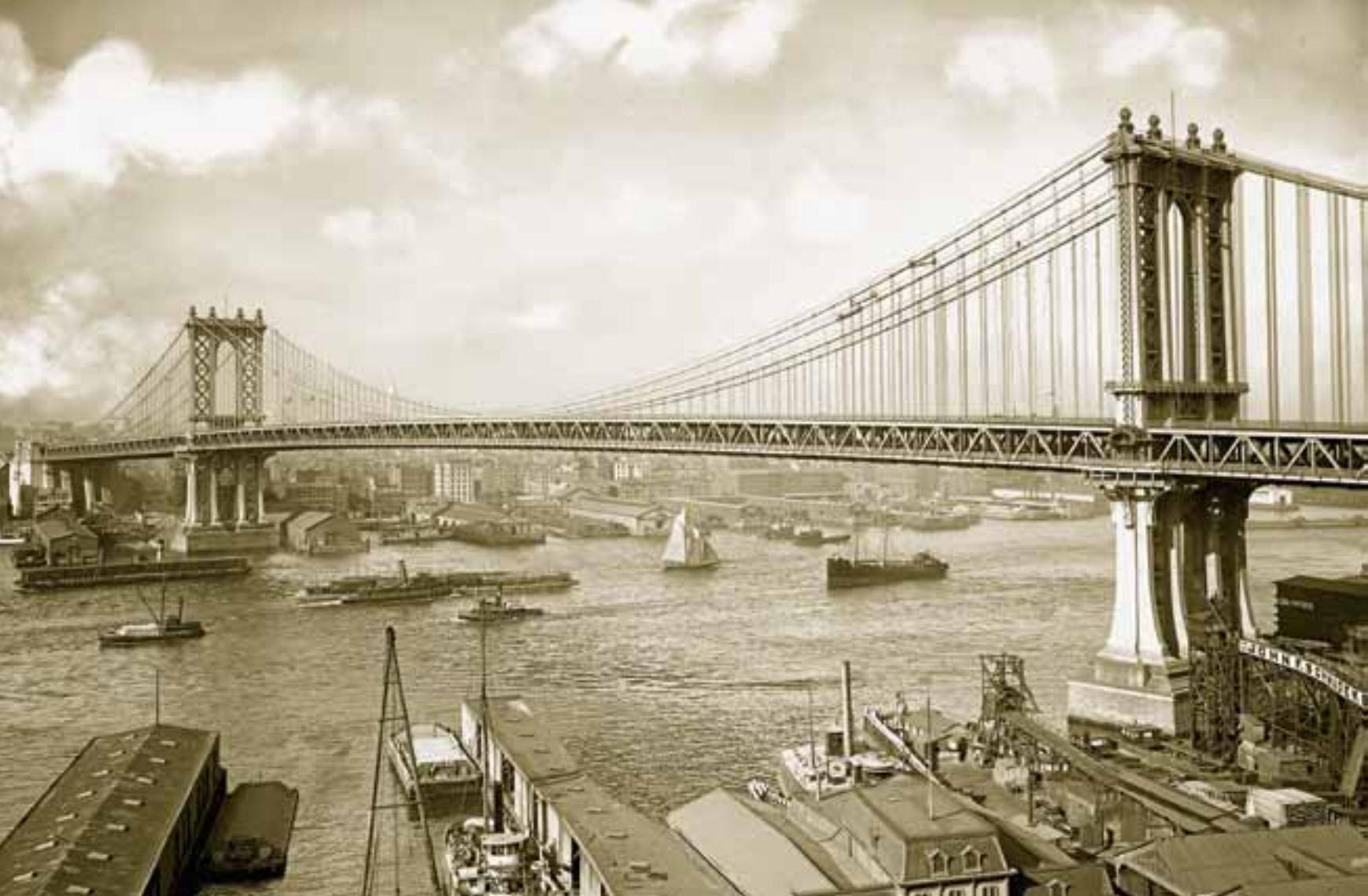
Сооружение Манхэттенского моста, 1909 г.
