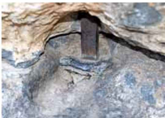
ЖЕЛЕЗНАЯ СТЯЖКА В КАМЕННОЙ КЛАДКЕ ХРАМА ГАРНИ. АРМЕНИЯ
