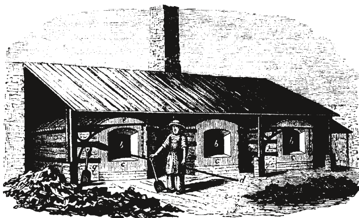
БАТАРЕЯ ИЗ ТРЁХ УЛЬЕВЫХ ПЕЧЕЙ С ОБЩЕЙ ДЫМОВОЙ ТРУБОЙ
