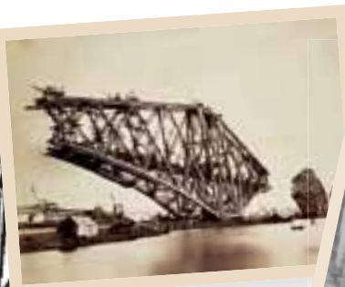
«Великий» Фортский мост: в период строительства; окончательный вид
