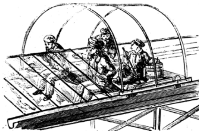
Сооружение Хрустального дворца: вверху – подъем арки и фермы для закрепления на чугунных колоннах; внизу – остекление крыши с помощью передвижных тележек
