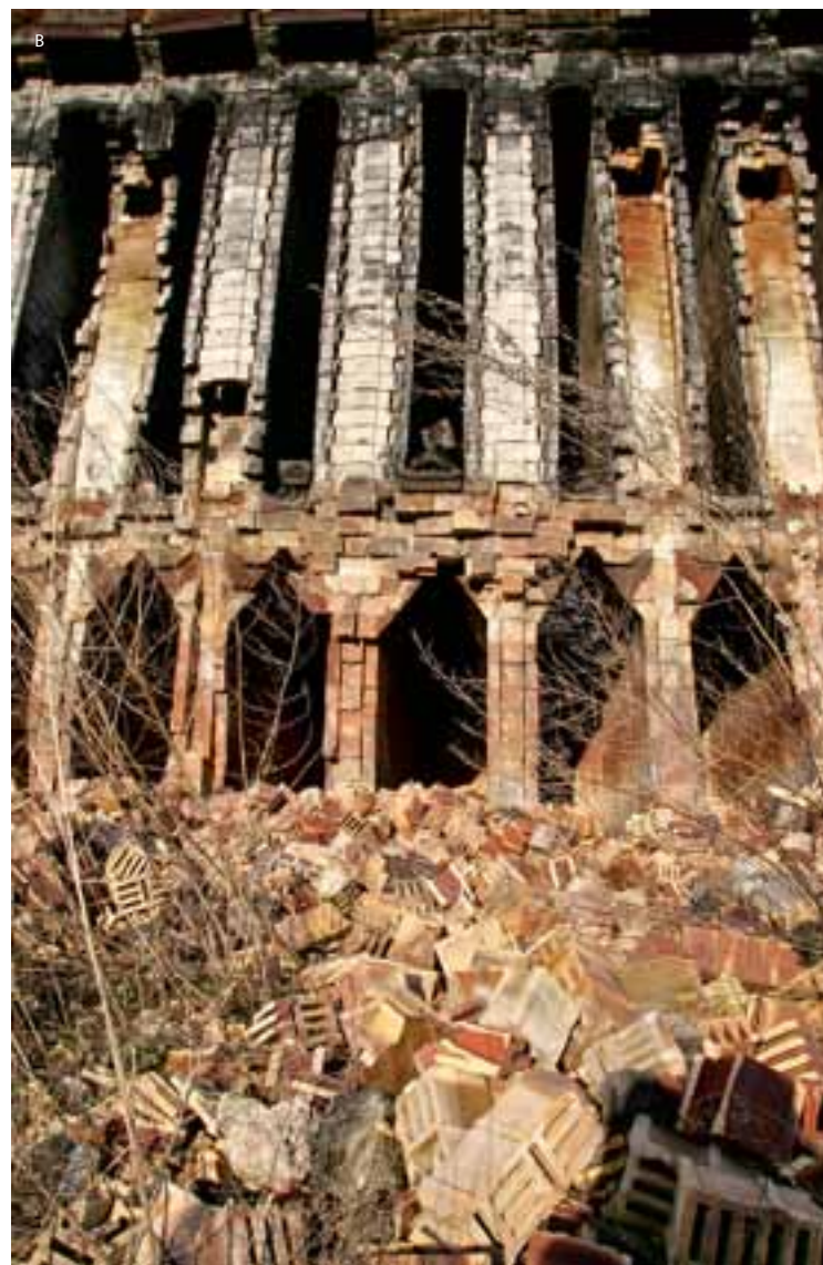
Разрушенная коксовая батарея системы Копперса, завод JOLIET WORKS компании U.S. STEEL, построена ок. 1908 г.:
