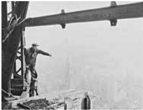
СТРОИТЕЛЬСТВО EMPIRE STATE BUILDING
