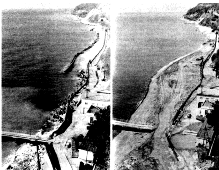
Рис. 2. Северная окраина Гагры, район санатория «Украина». Снимок слева сделан 1 февраля 1982 г. Строительство бетонных берегоукрепляющих сооружений привело к низовому размыву на смежном участке. На снимке справа тот же участок 1 мая 1983 г. после отсыпки материала у мыса и осенне-зимних штормов сезона 1982/83 г., переместивших наносы к югу.
