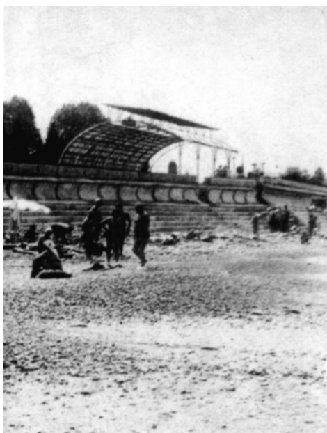
Рис. 4. Тот же участок в июне 1983 г. после энергичных отсыпок песчано-галечного материала
