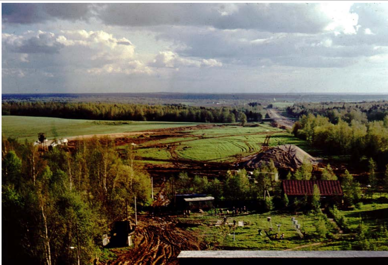
1974 г. Возле полигона началось строительство нового шоссе
