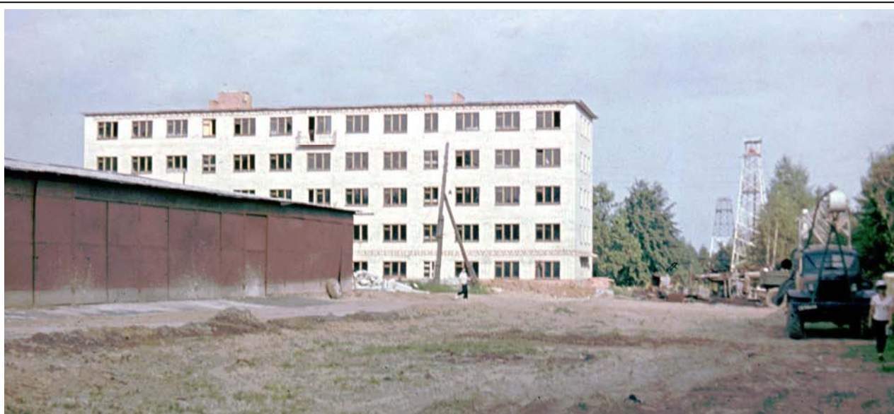
1972 г. Здание построено, начались отделочные работы
