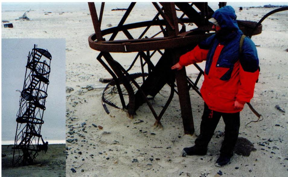
Рис. 2.2.4. Берег Печорского моря. Наблюдательная вышка повреждена в результате надвига припайных льдов на нагонную осушку
