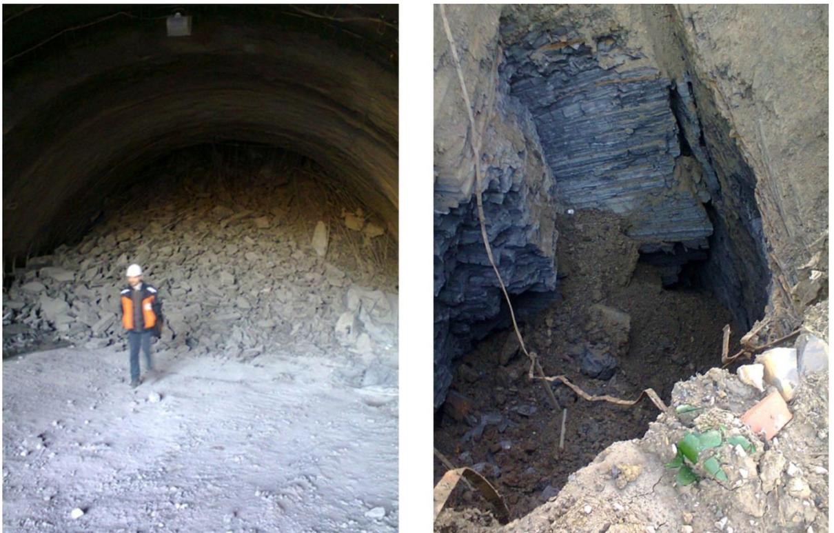
Рис. 2.7. Пример аварийной ситуации в припортальной части тоннеля №4а
