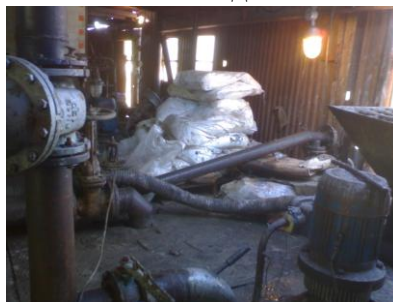
Рис. 4 Складирование химических реагентов в блоке емкостей
