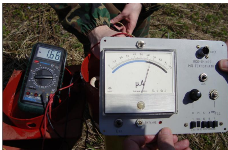
Рис. 4. Значение защитного потенциала и значение тока катодной защиты на 764 км нефтепровода «Александровское – Анжеро-Судженск»
