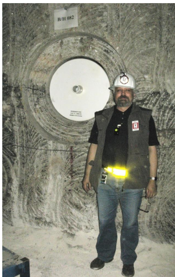
Рис.81. Устье горизонтальной скважины для размещения отходов дистанционного обращения (РН). Авторское фото.
