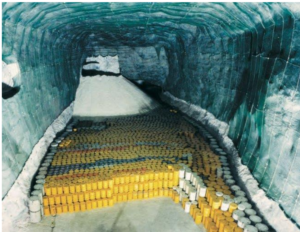
Рис. 75. Размещение РАО в подземных камерах хранилища Морслебен. Пустые пространства между бочками заполняются измельченной каменной солью.
