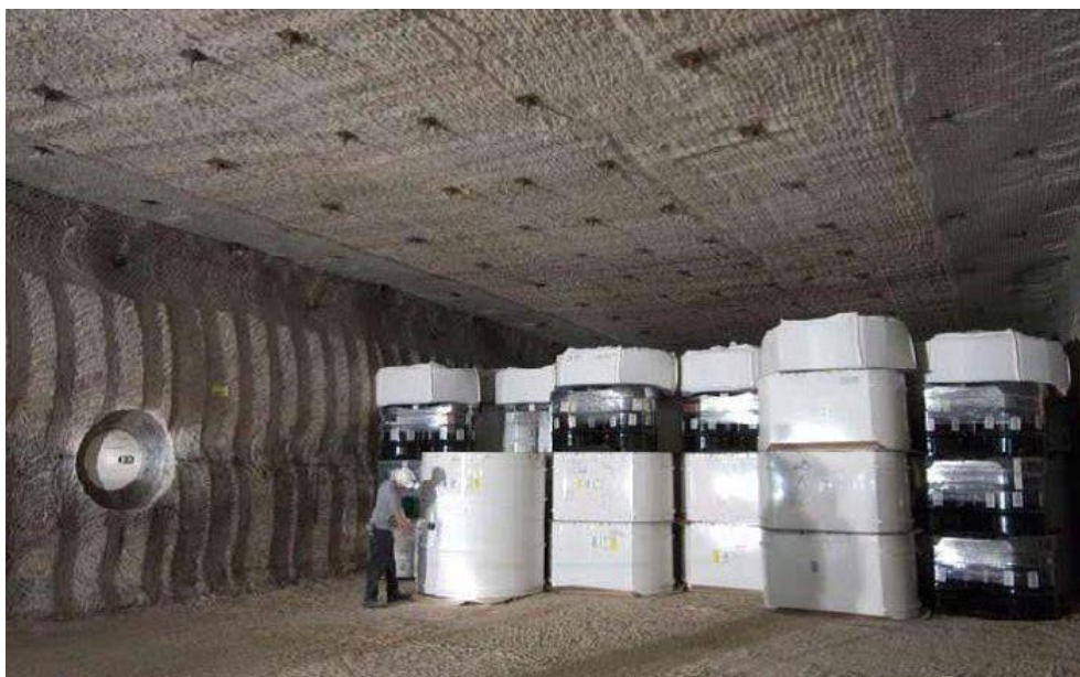
Рис. 80. Размещение контактно обрабатываемых отходов (СН) в подземных камерах WIPP [187].
