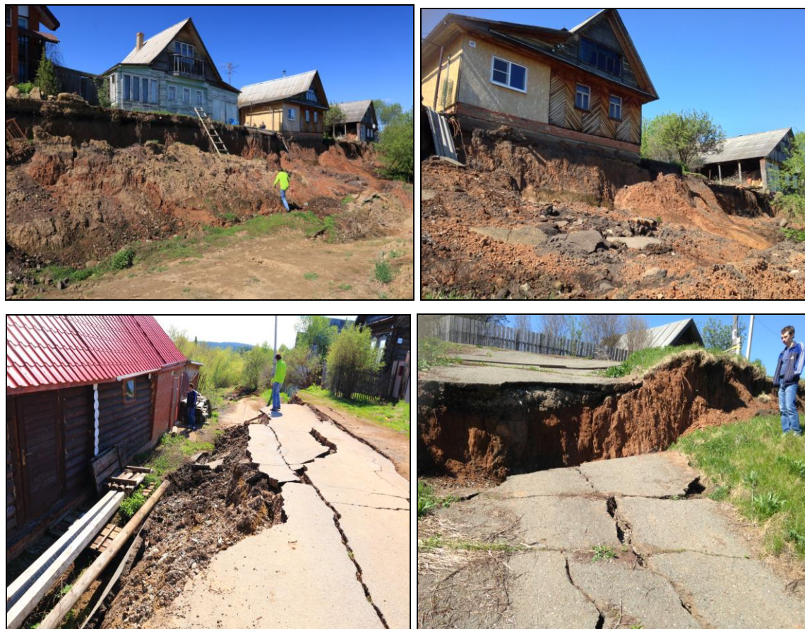
Рис. 27. Последствия сошедшего 13.04.2016 оползня в д. Докша. Склон правого борта долины р. Камы. Фото автора
