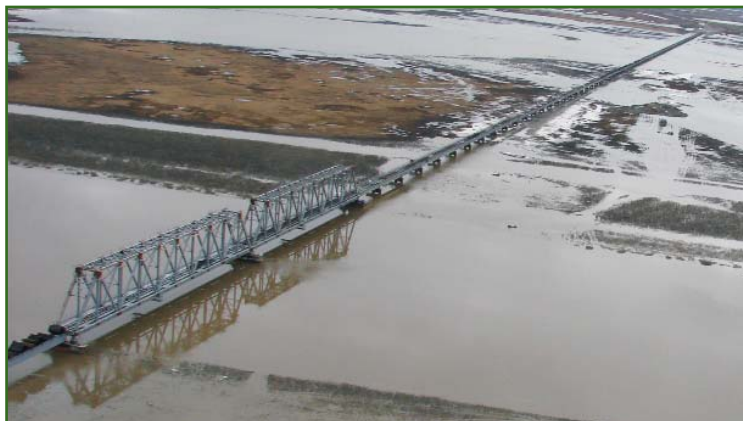
Рис. 2 Общий вид железнодорожного моста через р. Юрибей
