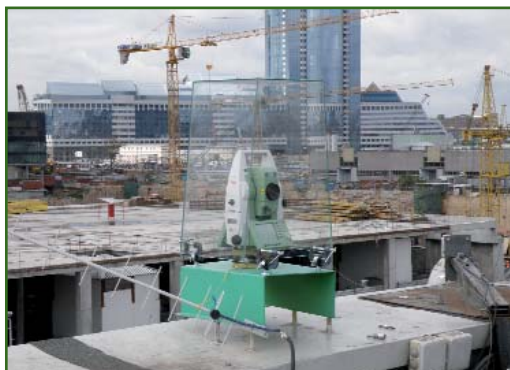
Рис. 6 Электронный тахеометр, установленный «Фирмой Г.Ф.К.» для автоматического контроля за смещениями высотного здания комплекса Москва-Сити
