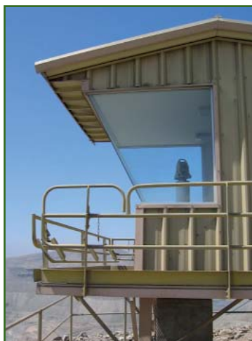
Рис. 7 Специальное помещение для размещения электронного тахеометра на карьере
