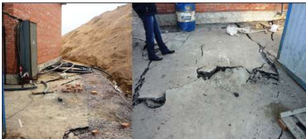
Рисунок 3.26 – Образование выпора в нижней части насыпи за счет отдавливания глин
