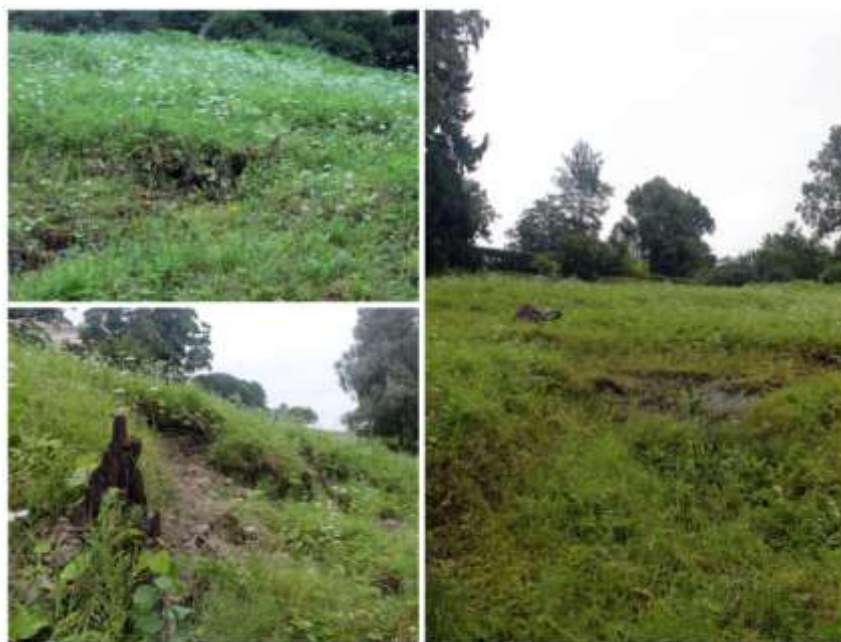
Рисунок 2.7 – Оползневые деформации на склоне р. Славянки (г. Павловск) (фотографии автора)
