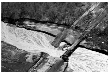
Рис. 5. Дорога и дамба в районе р.Бекеш, разрушенные грязевыми потоками. Фото Ю.В. Демянчука.
