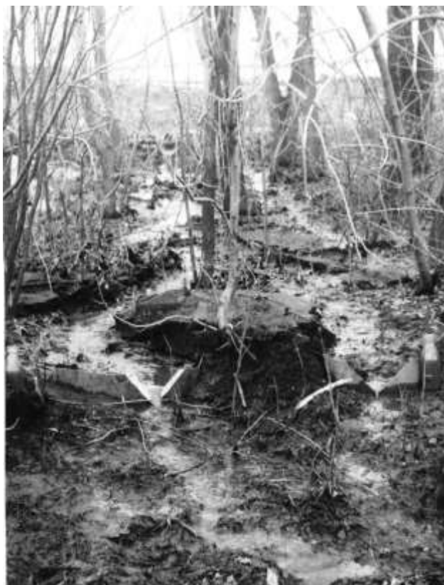
Рис. 3.53. Водослив-водомер на входе в лесную полосу (слева) и водосливы на ее выходе в период талого стока в марте 1985 года (фото Зубова А.Р.)
