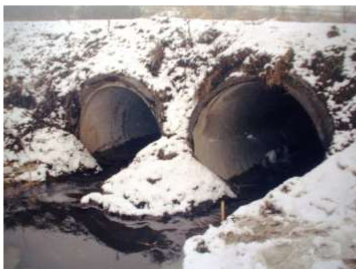
Рис. 3.28. Водосбросные трубы в теле плотины с линейками для замера напора воды перед ними (фото Зубова А.Р.)
