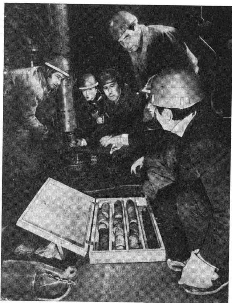
Рис. 1.4. Подъем и извлечение керна
