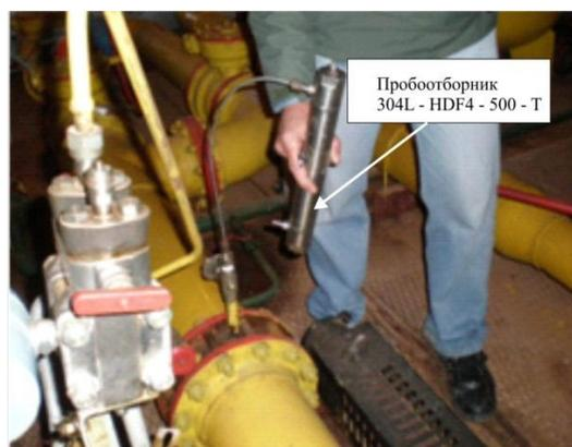
Рис. 11.2. Пример отбора проб газа в пробоотборник 304L-HDF4-500-T на Юрубчено-Тохомском месторождении
