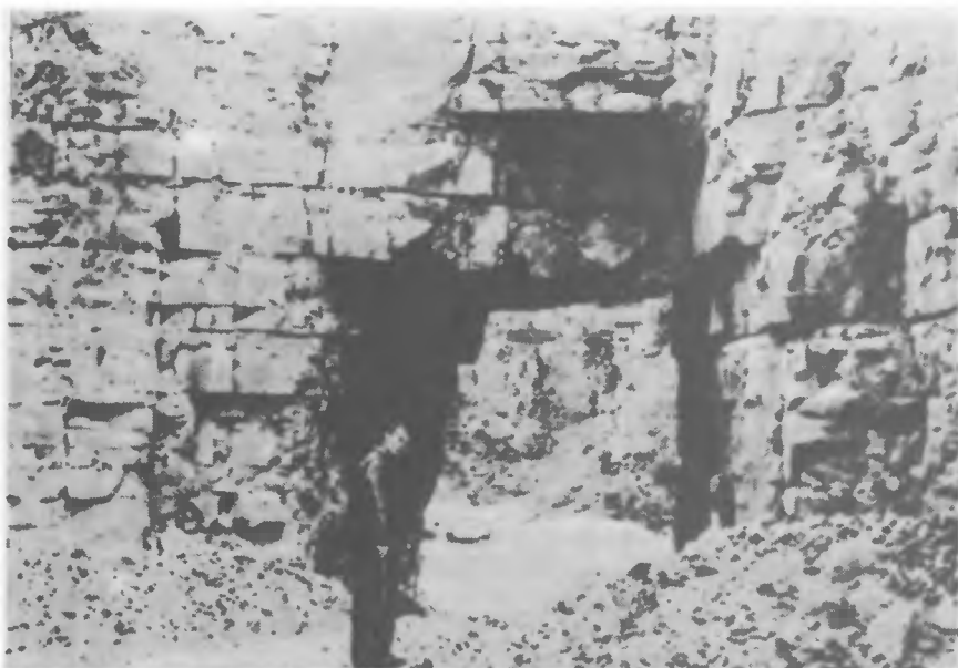
Рис. 15.4. Прямоугольная выработка в горизонтально-слоистом известняке в кровле выработки находятся «балки», не воспринимающие растягивающих напряжений
