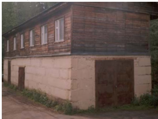
Старый дом преподавателей-геологов и склад оборудования, ЗБС, 2003 г.
