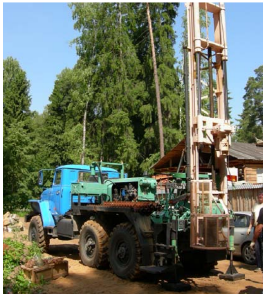
Буровая установка ПБУ-2-24, Верхние дачи ЗБС, 2009 г.
