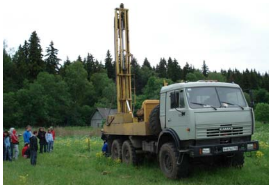
Бурение скважины, ЗБС, 2008 г.
