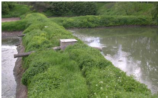
Очистные сооружения пансионата «Ёлочка», 2004 г.
