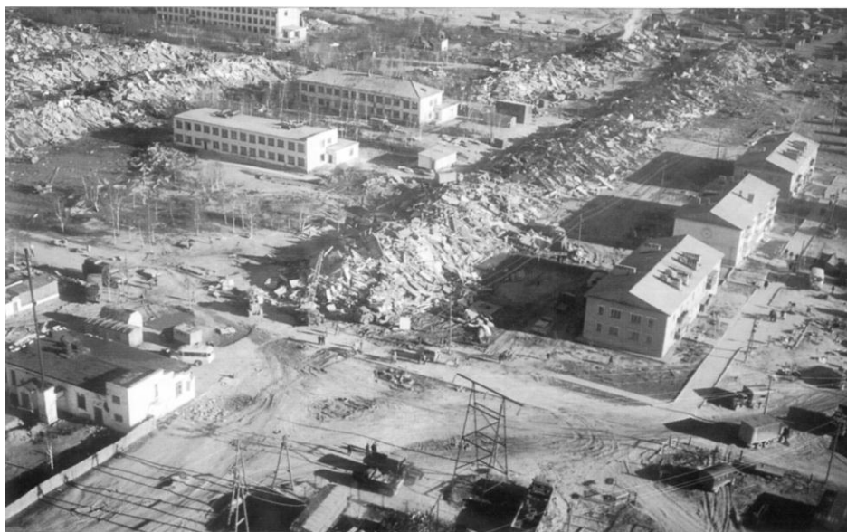
Рис. 10 Последствия землетрясения в пос. Нефтегорск 99 (Фото Г.Л. Коффа)
