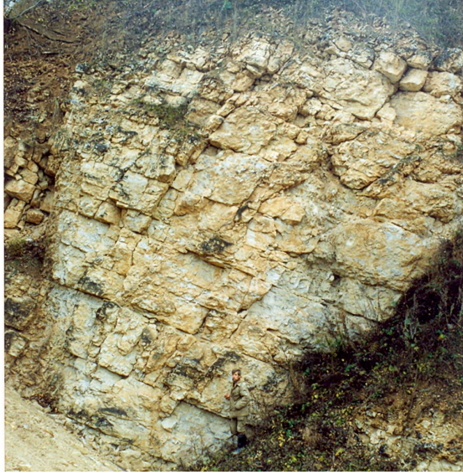
Рис. 5.28. Условия залегания и характер трещиноватости слоистых известняков в южном борту карьера (высота уступа более 8 м)
