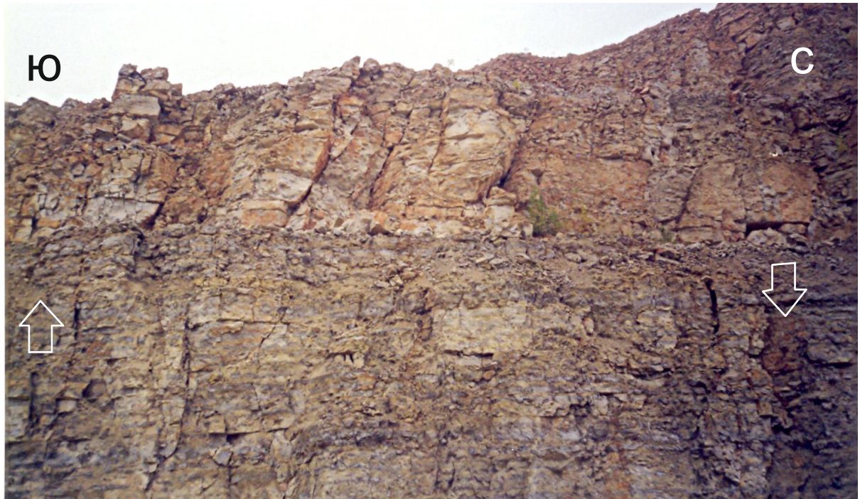
Рис. 5.25. Взбросовый характер трещиноватости в известняках в северо-западном борту Пудлинговского карьера
