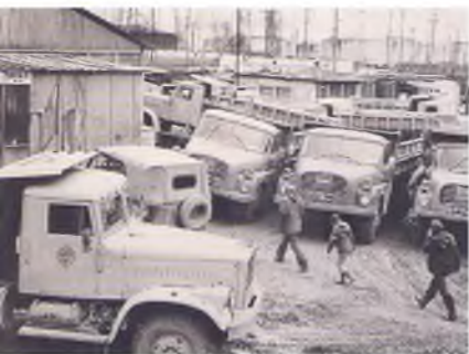
Возле временной столовой на Головных сооружениях. 1980 г.
