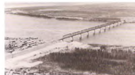
Мост через реку Усу.
