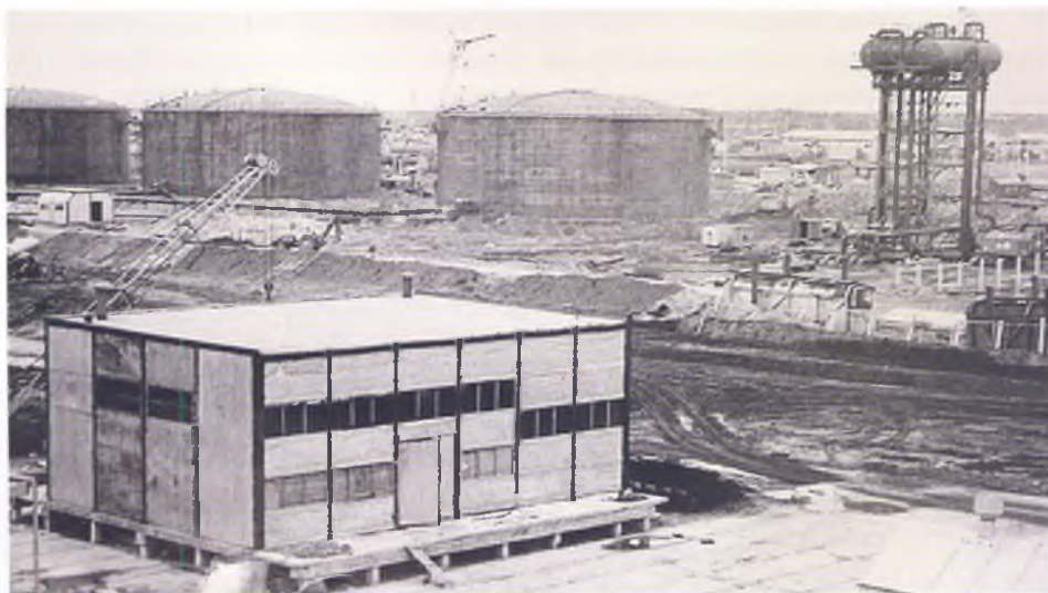
Строительство второй очереди УПН на Головных сооружениях. 1982 г.
