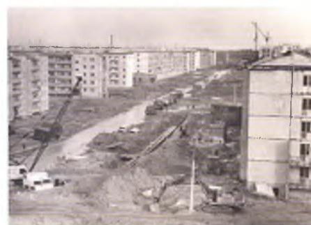
Усинск, ул. Строителей. 1977 г.
