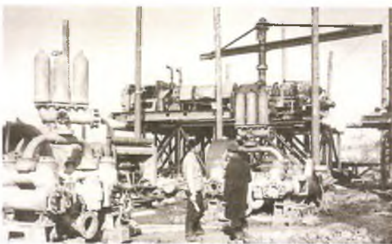
Монтаж оборудования буровой №3-Вуктыл.
