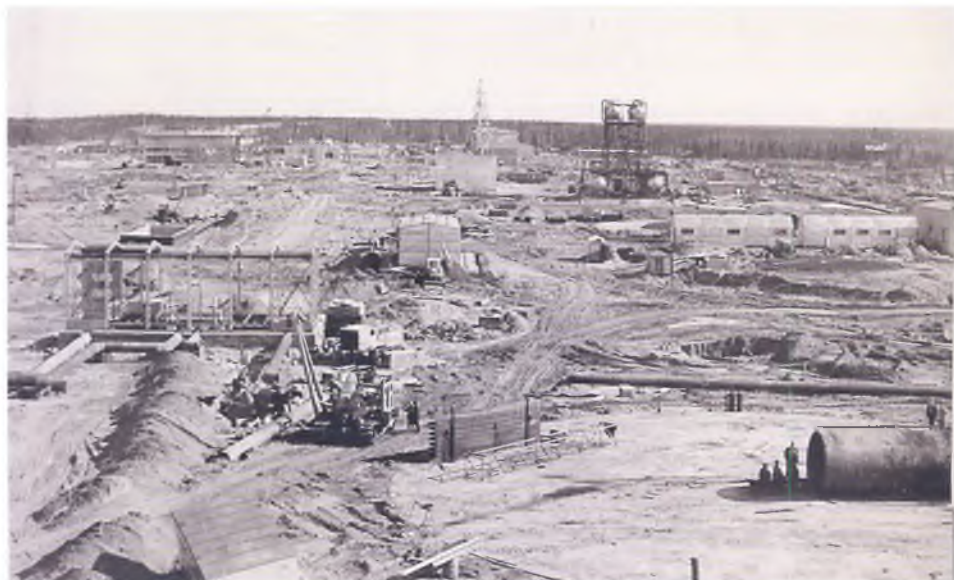
Строительство УПП на Головных сооружениях. 1973 г.
