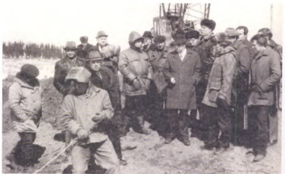
В гостях у строителей пятого моста через реку Колва на Харьягинском месторождении. Идёт подготовка к забивке первой сваи под опору моста. Второй справа – главный инженер треста «Коминетфеспецстрой» П.Ф. Кучеров, третий во втором ряду – начальник мостостроительного участ- ка И.М. Покладов.
