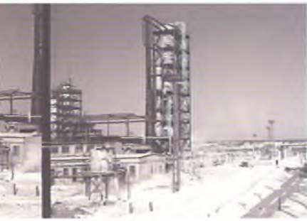
Установка термического крекинга.
