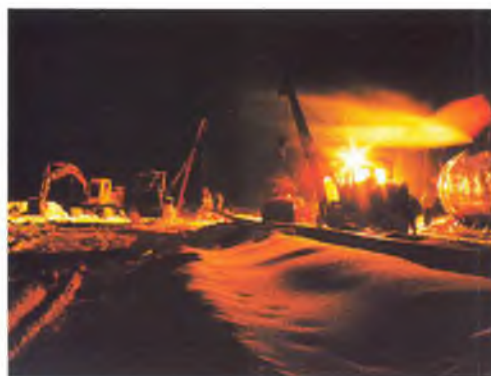
На прокладке нефтепровода под дном Печоры. Вечером 24 февраля работы начались на правом берегу Печоры, утром 25 февраля труба длиной 1750 м вышла на левом берегу. 2002 г.
