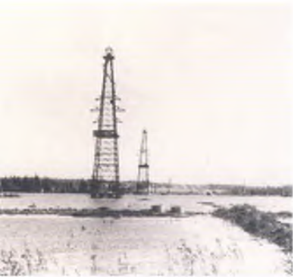
Переход ЛЭП-35 через реку Колву.
