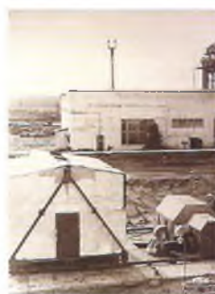
Открытая временная насосная станция и укрытие для ремонта насосных агрегатов на НПЗ «Уса». Начало 1980-х гг.
