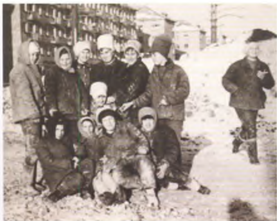
Бригада Веры Лазаревич участвовала в строительстве первых домов посёлка. 1969 г.
