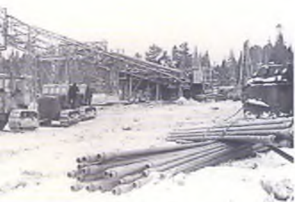
Монтаж буровой установки, 17 декабря 1981 г.
