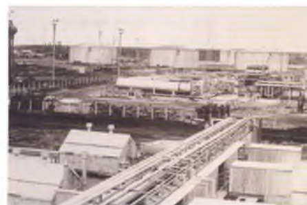
Головные сооружения, установка подготовки нефти. 1976 г.
