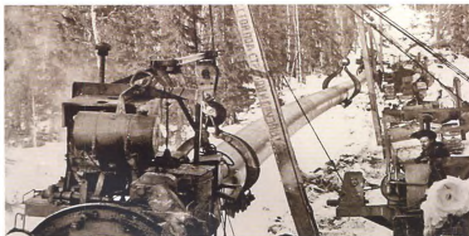
Строительство нефтепровода Ухта – Уса.
