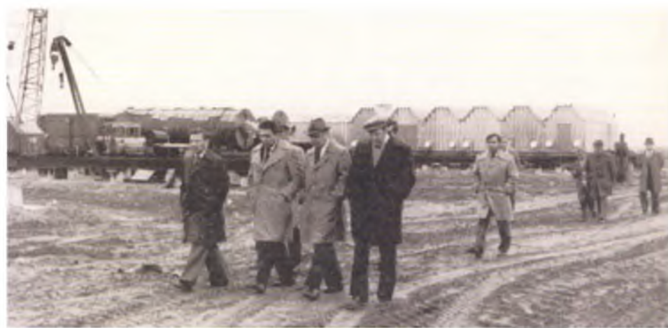
На участке паротеплового воздействия. Слева направо: секретарь Коми обкома КПСС Н.П. Зашихин, заместитель министра Миннефтегазстроя СССР М.Х. Хуснутдинов, заместитель генерального директора объединения «Коминнефть» В.Н. Мусиенко, начальник нефтедобывающего управления «Усинскнефть» В.А. Усик.
