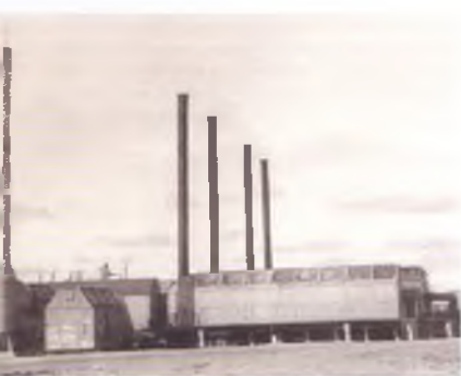
Парогенерирующий комплекс на залежи тяжелой нефти Усинского месторождения.
