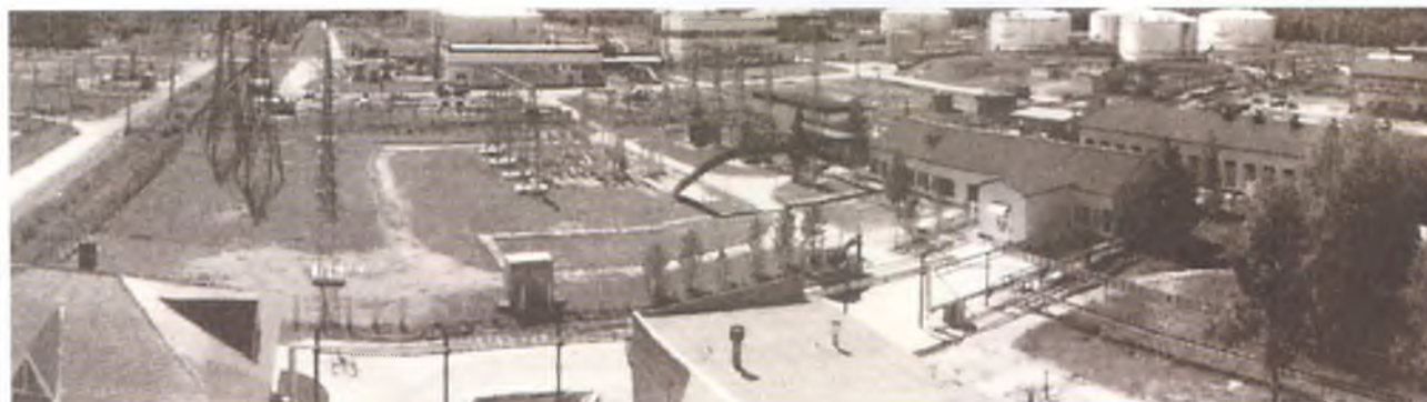
Ухтинская нефтеперекачивающая станция.
