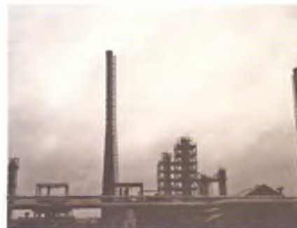
Установка каталитического риформинга.
