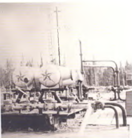
Замерная установка на скважине № 11.
