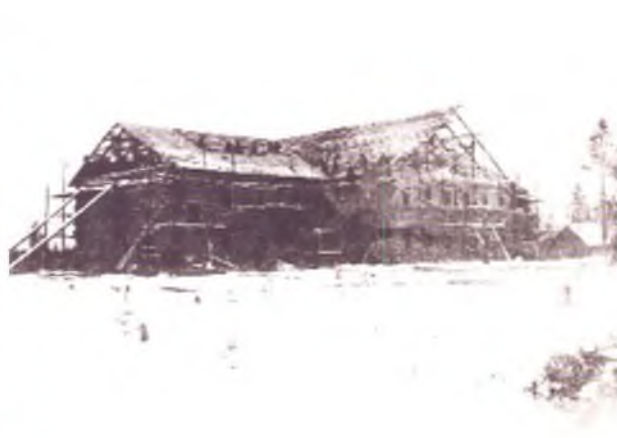
Строительство химзавода №1. 1931 г.
