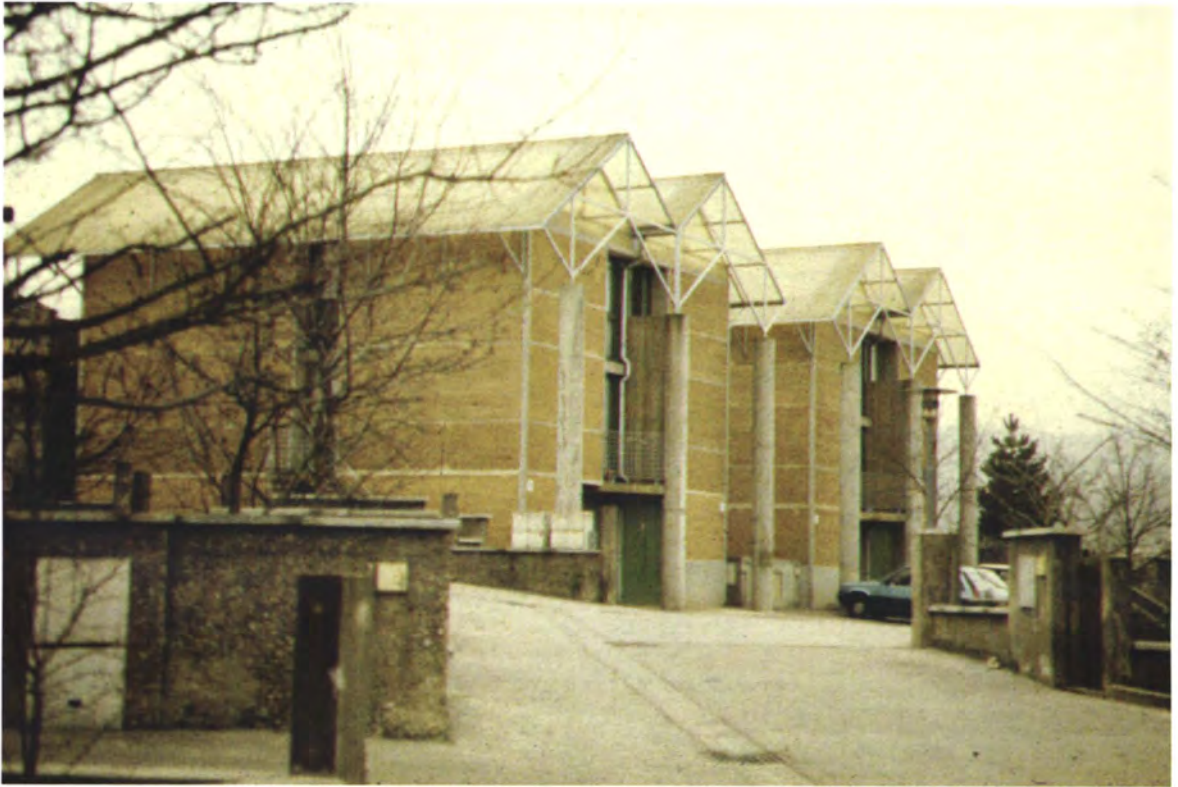
PLATE 3. Rammed Earth Housing, Domaine de la Terre at l'Isle d'Abeau, Lyon, France (1982–85).
