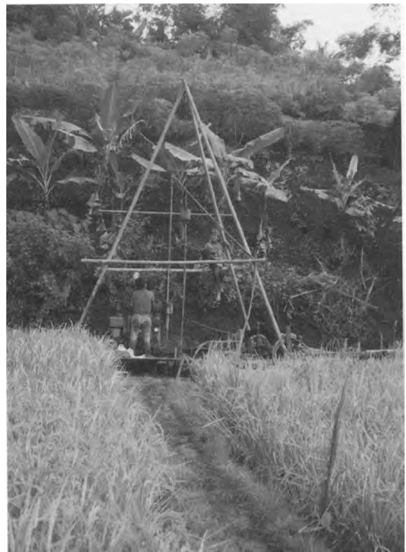
FIG. 7.11. Tripod boring rig.
