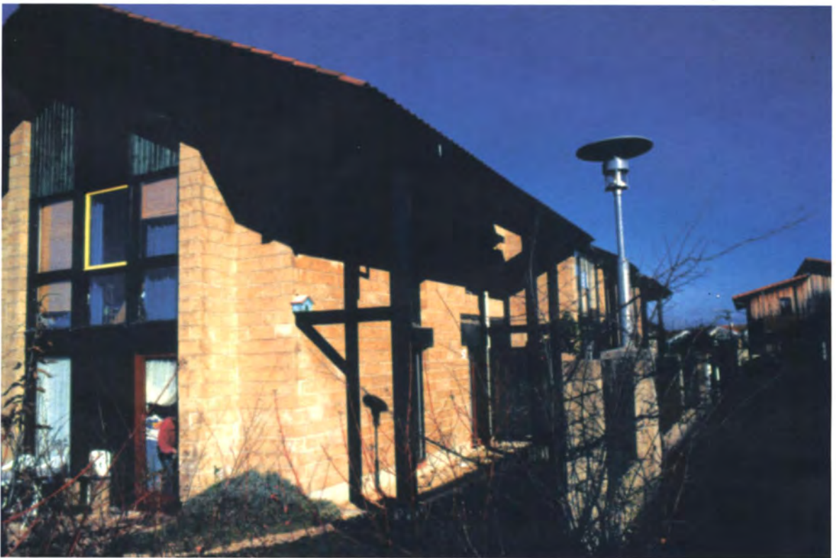
PLATE 4. Compressed block housing, Domaine de la Terre, l'Isle d'Abeau, Lyon, France (1982–85).
