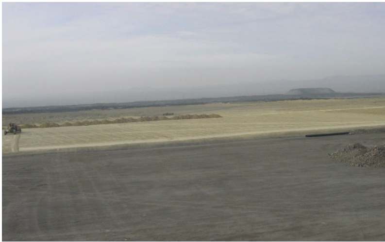
Рис. 6.6. Укладка защитного экранирующего слоя из бентонитной глины на 4-м ярусе ПВ
