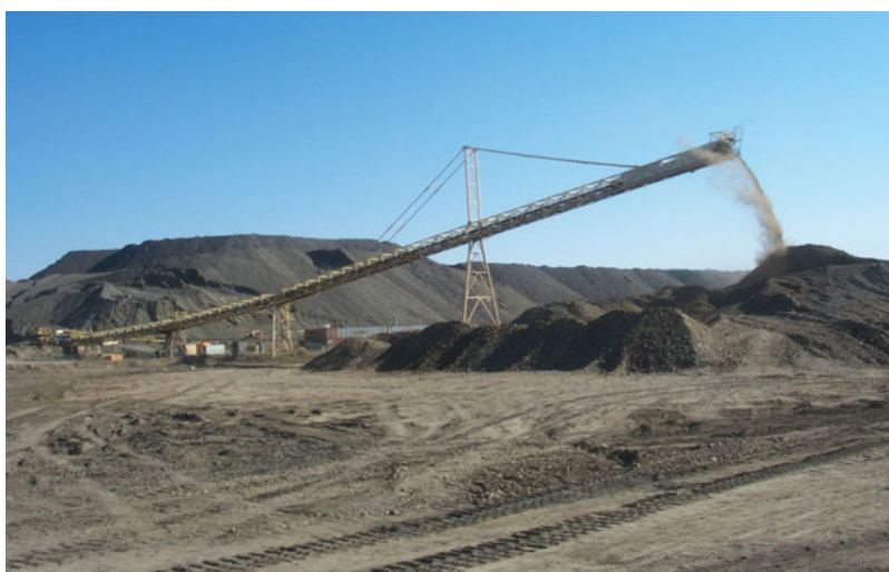
Рис. 2.10. Общий вид буферного склада в конвейерной транспортной системе
