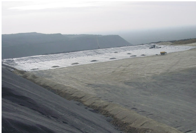
Монтаж дренажной системы подушки выщелачивания
