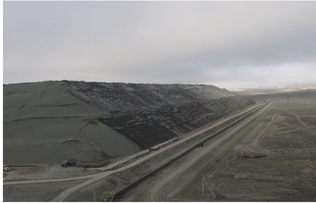
Рис. 5.17. Проведение орошения откосов подушки выщелачивания
