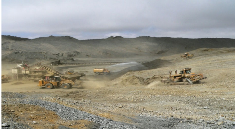
Рис. 2.2. Разработка склада наклонными слоями
