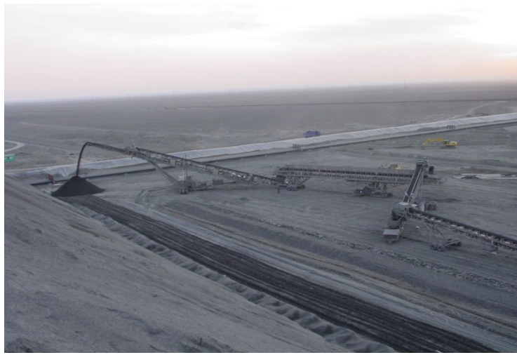
Отсыпка рудного штабеля на подушке выщелачивания
