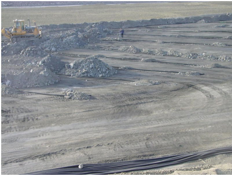
Сооружение дренажного слоя основания подушки выщелачивания
