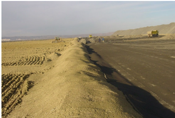
Сооружение защитного экранирующего слоя с использованием бентонита
