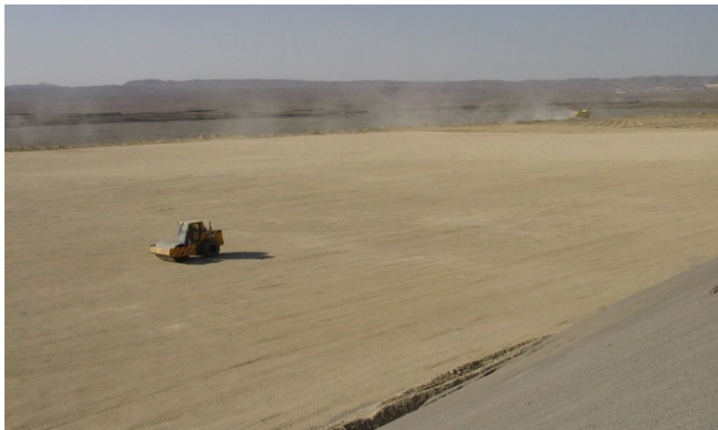
Рис. 6.7. Процесс трамбовки бентонитной глины на 4-м ярусе ПВ рудника ЦКВЗ
