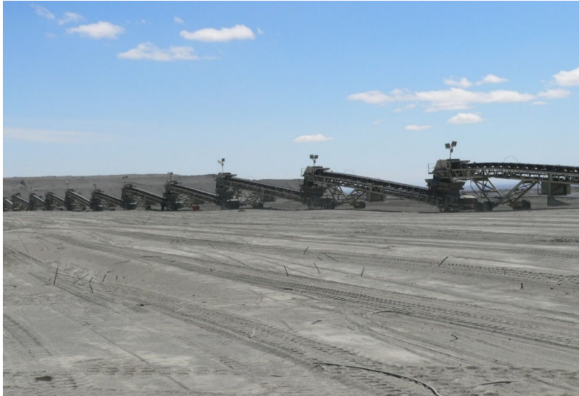
Рис. 2.11. Самоходные конвейеры перегружатели на поверхности штабеля
