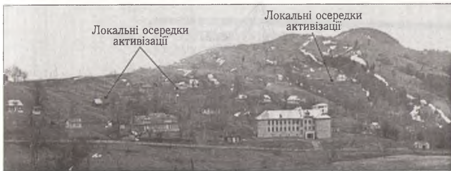
Мал. 31. Лівий схил ріки у межах центральної частини в с. Буковець з ділянкою тимчасово-стабілізованого зсуву та осередками активізації (під індивідуальне будівництво мало-перспективна. Потребує детального вивчення і значних вкладень коштів на інженерну підготовку схилу. В районі розміщення кількох будівель потрібно вжити заходи для стабілізації схилу; фото Г. Рудька)
