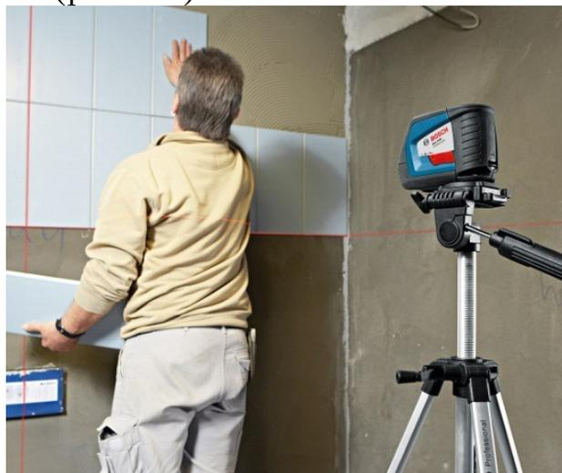
Рис. 116. Нивелир «Bosch GLL 2-50 Professional», используемый в качестве ориентира для повышения точности ремонтных и строительных работ
