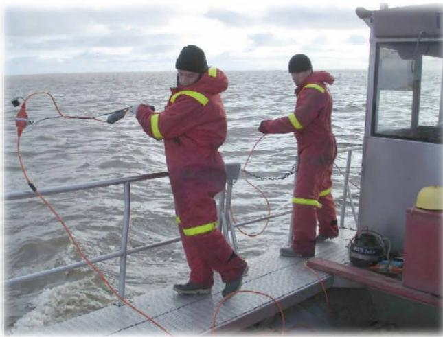
Рис. 1.28 – Раскладка линий приема сейсмических кос с катамарана в мелководной транзитной зоне Обской губы Карского моря
