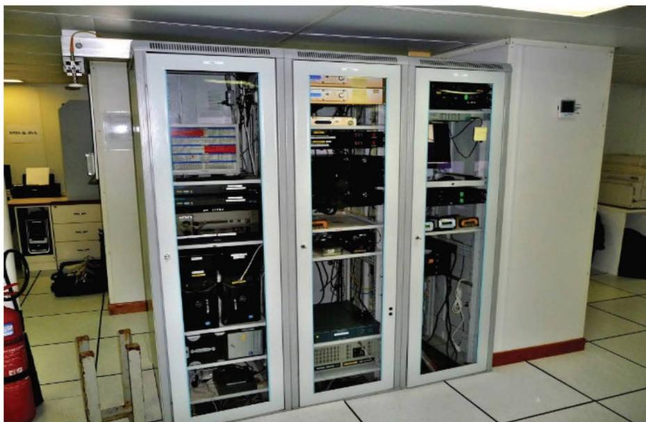
Рис. 1.34 – Аппаратурная стойка интегрированной системы навигации
