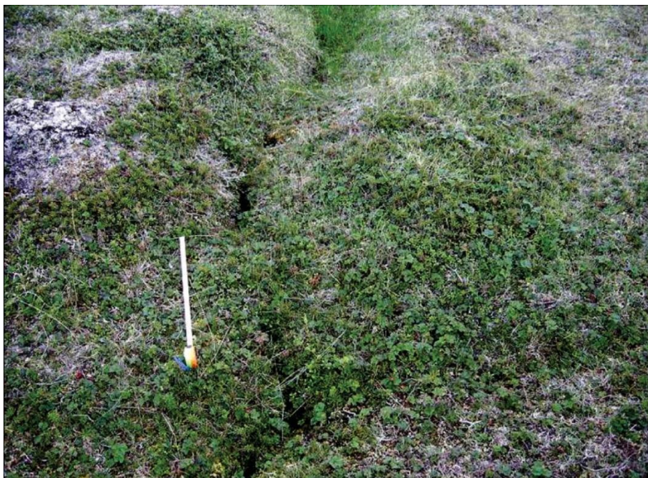
Рис. 5.3. Открытая морозобойная трещина, полуостров Ямал, Западная Сибирь © А. Губарьков
