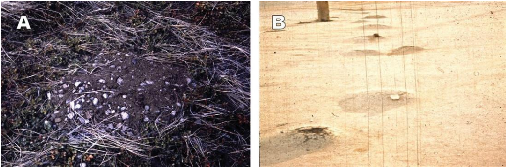
Рис. 10.14. Морозные фурункулы: А, развитый в альпийских тундрах на вершине Харт-Маунтин, Альберта и В, разбивающий тротуар в центре города Якутска, через год после того, как он был вымощен. © S. A. Harris.
