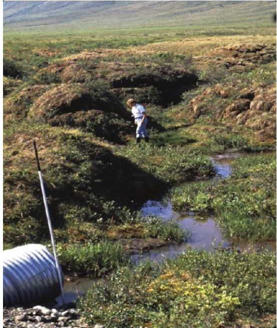
Рис 3.19. Результаты размещения дорожного водопровода слишком низко в районе развития повторно-жильных льдов вдоль шоссе Демпстер, территория Юкон, на следующий год. © S. A. Harris
