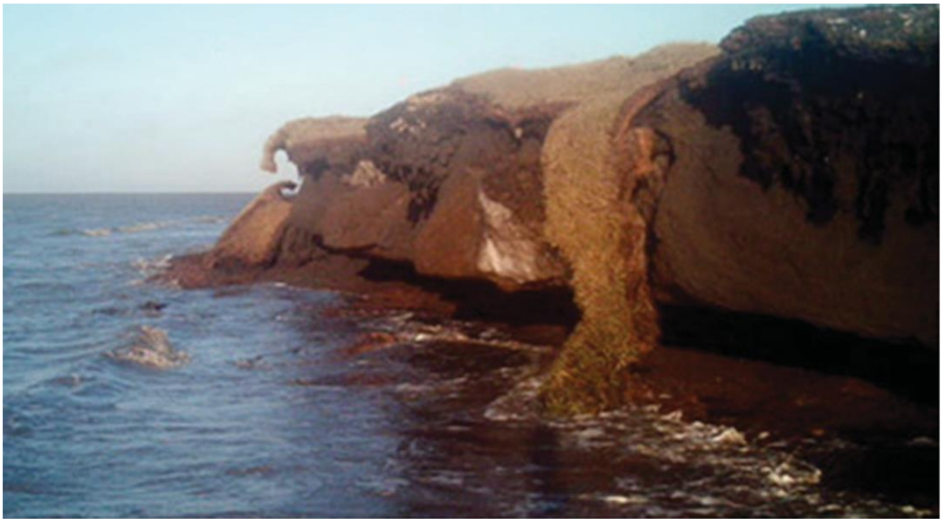
Рис. 11.38. Сплыв активного слоя ( active layer detachment slide ). Обратите внимание на пластовый лёд, образующий выступ, и вырезанную волноприбойную (абразивную) нишу на уровне воды
