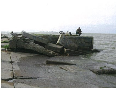
Фото 4. Техногенные преобразования (берегозащитные сооружения м.Дубовской)
