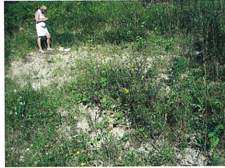
Фото 8. Оползень (пос. Александровка, р. Кузьминка)
