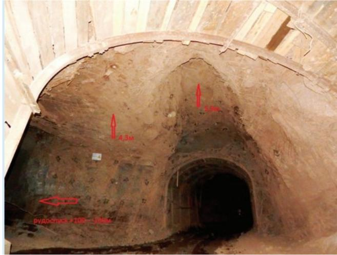
Рисунок 1.19 – Зона обрушения пород на сопряжении спирального съезда гор. +100 с рудоспуском на гор. +50 на руднике Айхал [32]
