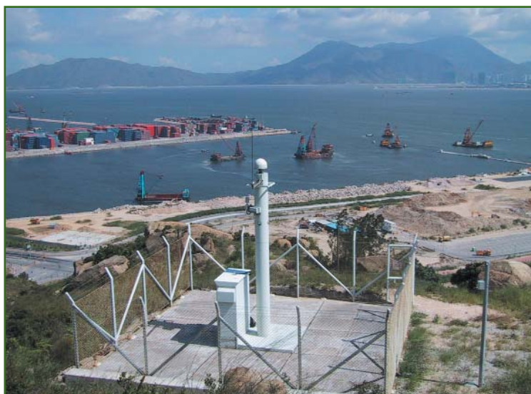
Рис. 1 Базовая станция, установленная в порту
