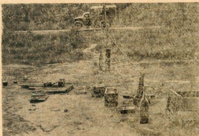
Рис. 55. Отбор проб воды из скважины с помощью глубинных пробоотборников
