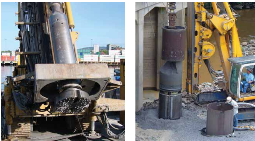
Рис. 3.9. Бурение больших скважин кластерными пневмоударниками компании Atlas Copco
