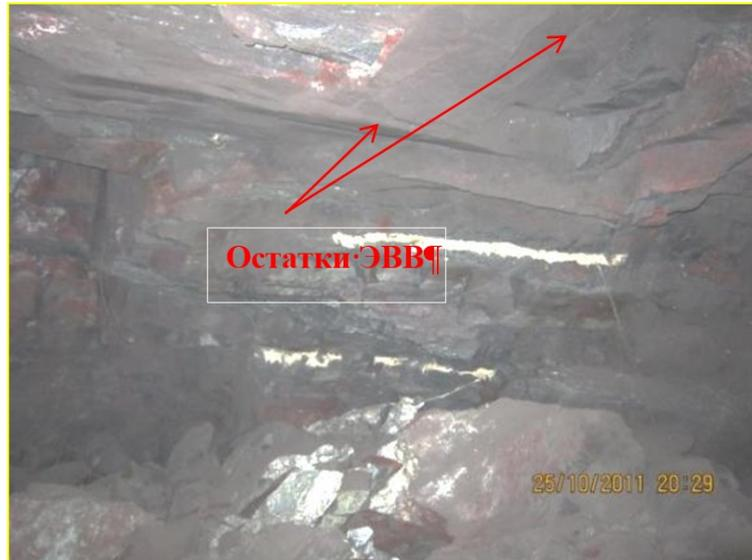
**Рис. 72.** Остатки ЭВВ на стенках контурных шпуров на Оленегорском подземном руднике
