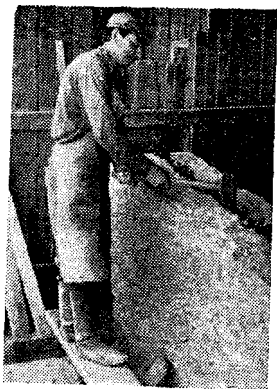
Рис. 15. Раскол блока при помощи клиньев и кувалды
