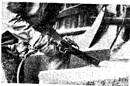
Рис. 19. Разметка контрольной линии
