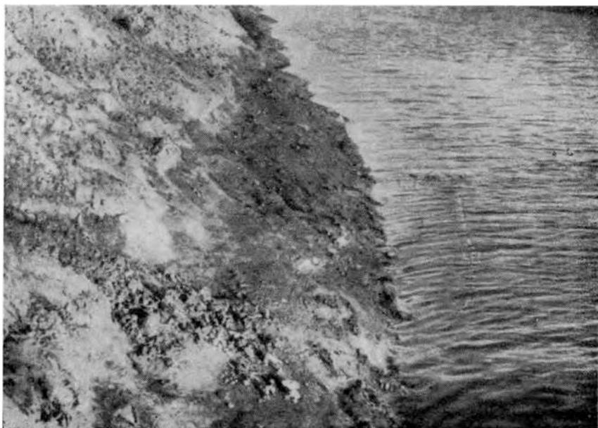
Рис. 94. Размыв откосов канала в лёссовых породах
