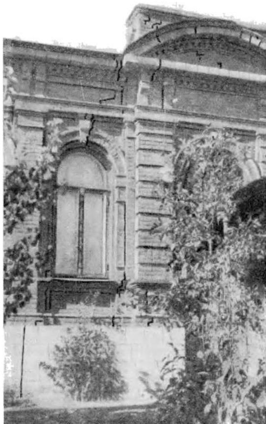
Рис. 88. Деформация одноэтажного здания
