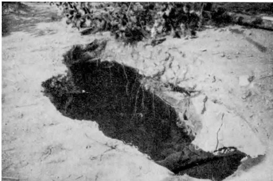
Рис. 77. Провал поверхности лёссовых пород в результате длительной течи водопроводных труб
