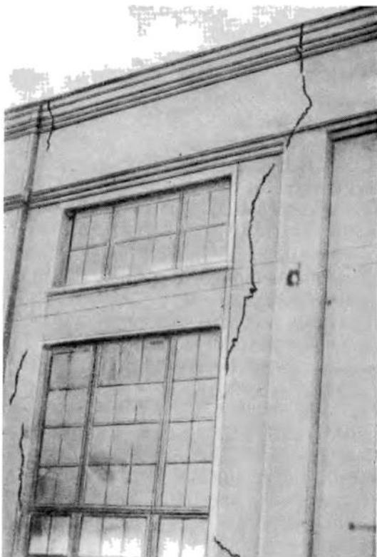
Рис. 91. Деформация промышленных сооружений, вызванная подъемом уровня грунтовых вод
