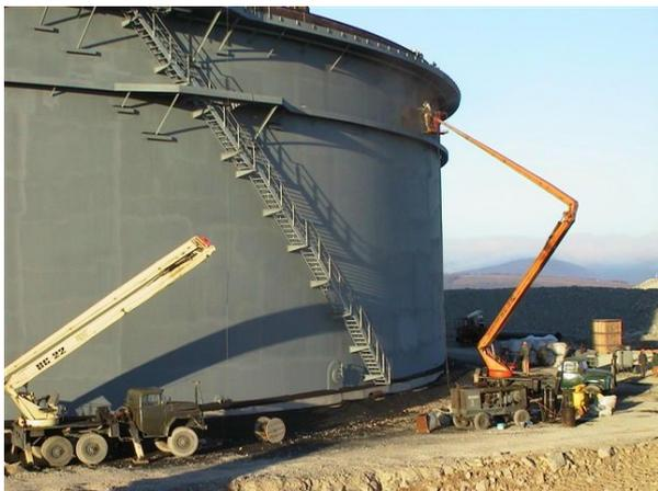
**Рис. 7.9. Нанесение изоляционного покрытия на наружную поверхность стального резервуара**
