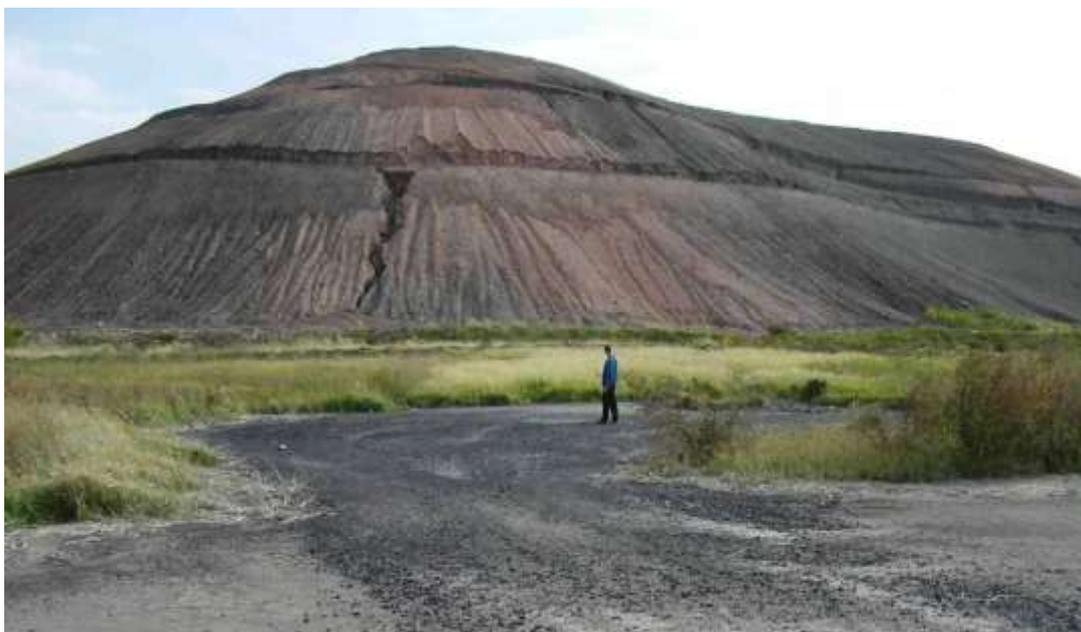
Рис. 1.7. Переформированный отвал шахты «Матросская» с промоинами и вынос продуктов эрозии на прилегающие сельхозугодия
