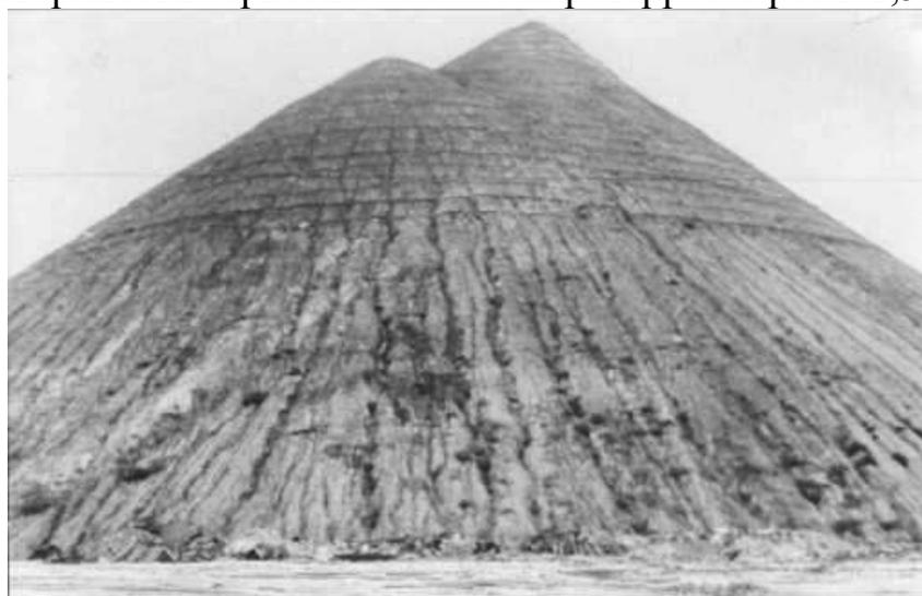
Рис.4.12. Микротеррасирование поверхности террикона №1
