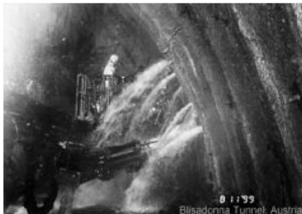
Рисунок 89: Доступ воды, контролируемый посредством заранее установленных труб до применения набрызгбетона
