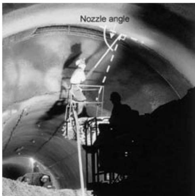
Рисунок 91: Угол сопла оказывает решающее влияние на отскок Nozzle angle- Угол сопла
