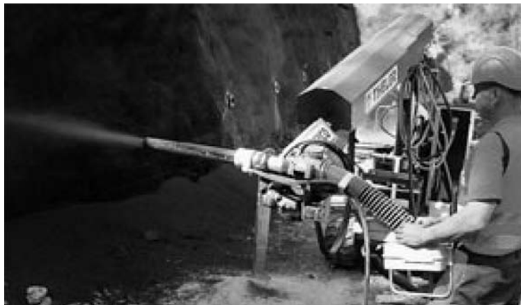
Рисунок 40: MEYCO® Rama4 манипулятор на мобильном распылительном оборудовании MEYCO® Oruga в действии при креплении откосов
