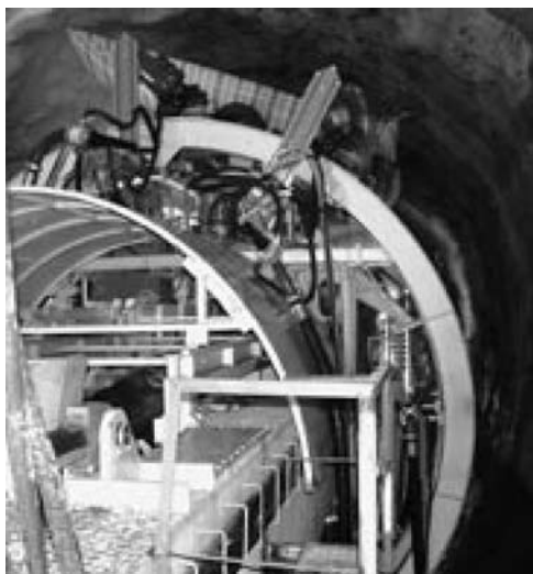
Рисунок 45: Решение, разработанное Меусо Equipment: Манипулятор распыления MEYCO® Robojet объединяется с тоннелепроходческим комплексом большого диаметра.
