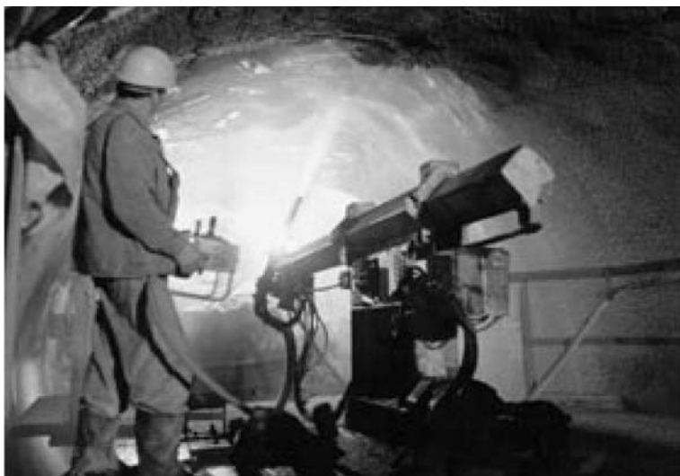
Рисунок 44: Решение, разработанное Меусо Equipment: Манипулятор распыления MEYCO® Robojet установленный на тоннелепроходческих комплексах малого диаметра.
