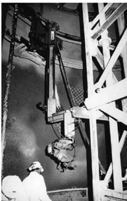
Рисунок 42: Пример распылительного манипулятора MEYCO® для шахтных стволов
