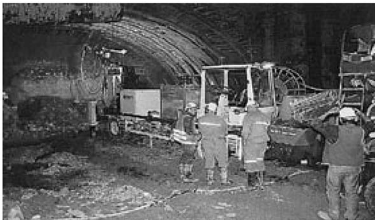
Рисунок 81: Автоматизированный набрызг обеспечивает высшее качество набрызгбетона
