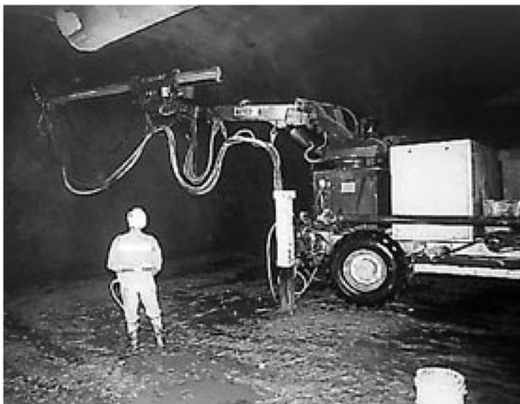
Рисунок 27: Современный набрызгбетон: Автоматизированный набрызг с использованием стальных фибр и прогрессивных добавок.
