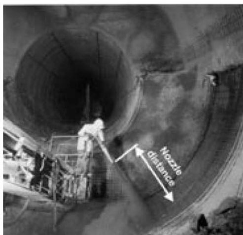
Рисунок 92: Расстояние между соплом и породой влияет на отскок и уплотнение. Nozzle distance- Расстояние до сопла
