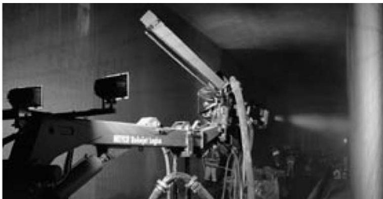
Рисунок 46: Нанесение пожарозащитного раствора Meuso FIX Fireshield 1350 с MEYCO® Logica15
