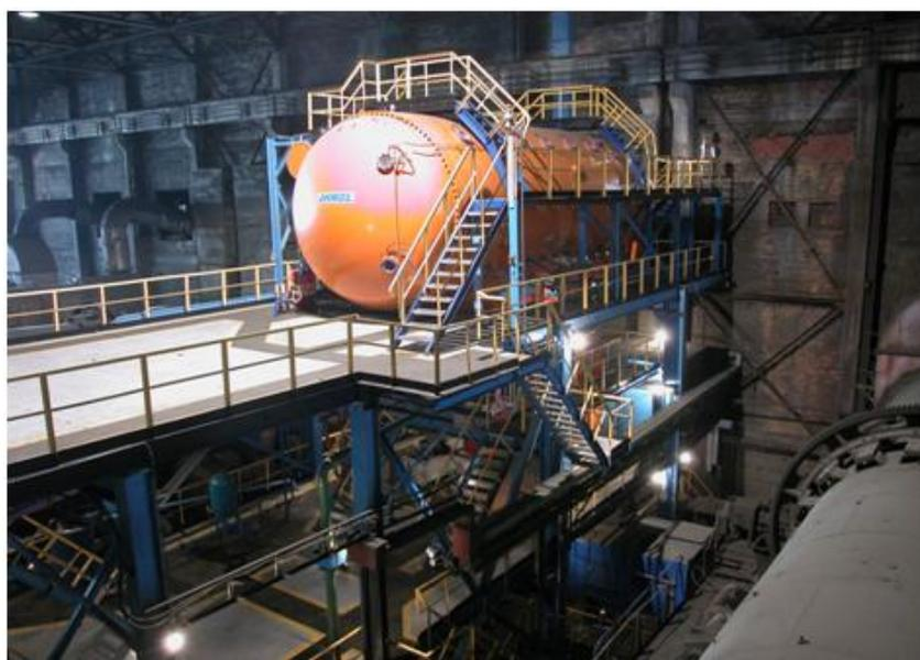
Рис. 4.7. Компоновка напорного фильтра HBF
