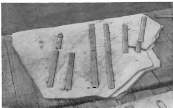
Рис. 58. Армирование пиленной плиты
