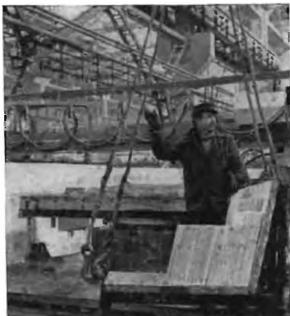
Рис. 76. Съем плит с окантовочного станка
