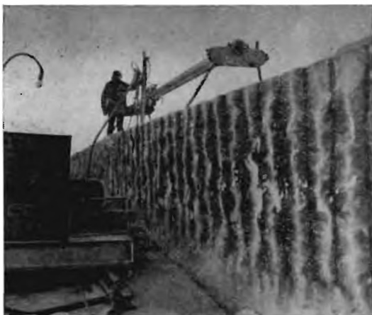
Рис. 7. Комбинированная добыча блоков с помощью установки строчечного бурения шпуров (сверху) и камнерезной машины СМ-428 (слева)
