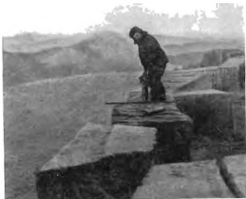
Рис. 80. Пассировка блоков
