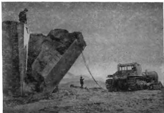
Рис. 5. Опрокидывание монолита, выпиленного канатной пилой
