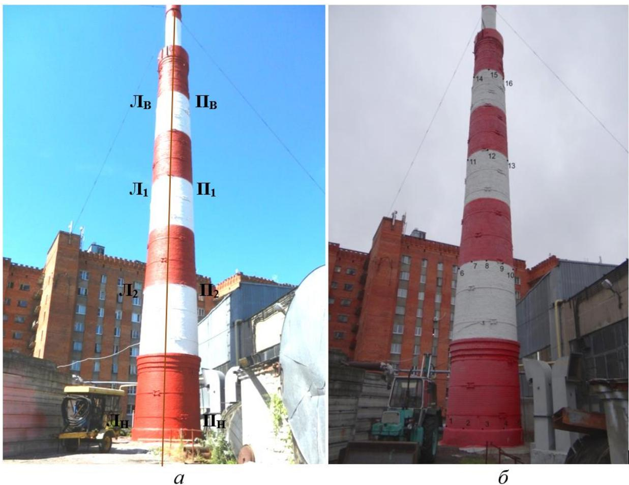
Рис.60. Исследуемая труба с референтной линией(а) реперные точки для координатных измерениях (б)
