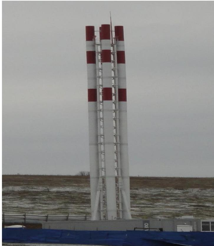
Рис.76. Фотография четырёхугольного куста дымовых труб
