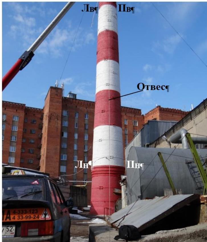
Рис.63. Схема использования отвеса в качестве референтной прямой
