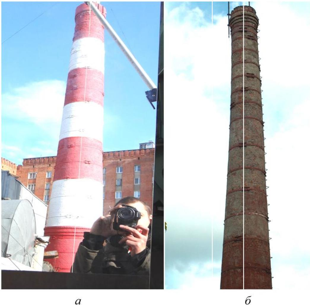
Рис.52. Фотография изображения трубы в плоском зеркале (а) и искривлённой трубы
