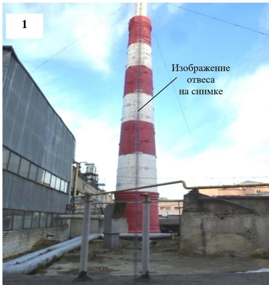
Рис.48. Исходное расположение отвеса по оси трубы
