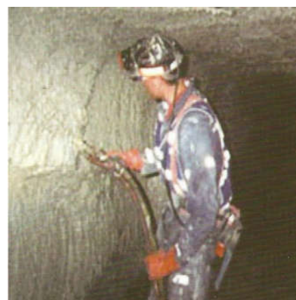
б) покрытие стенок выработки покрытием «Текфлекс»
