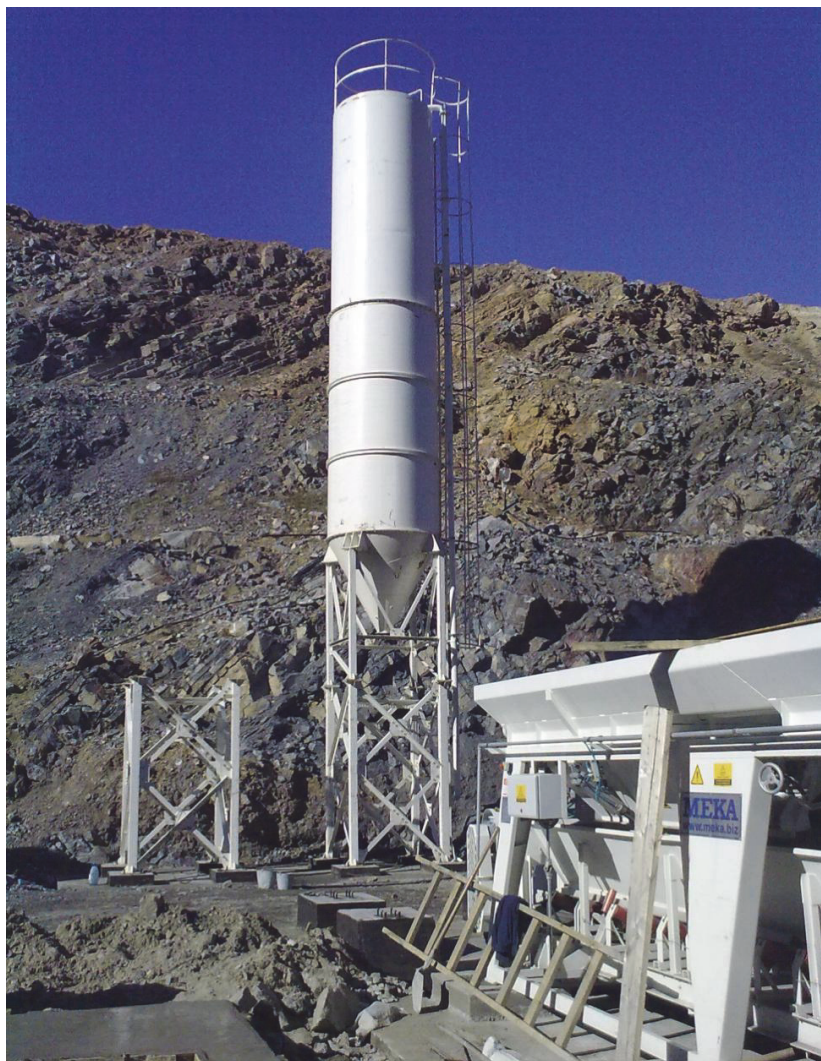
Рис. 1.5. БСУ MB-30WS (в процессе монтажа)
