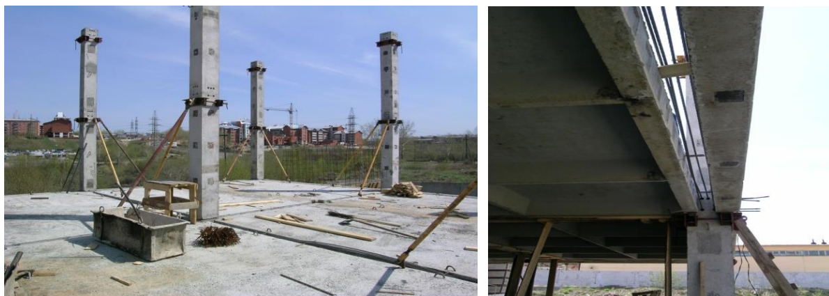
Рис. 17. Конструкции безригельного каркаса серии 1.120с «системы ИМС»
