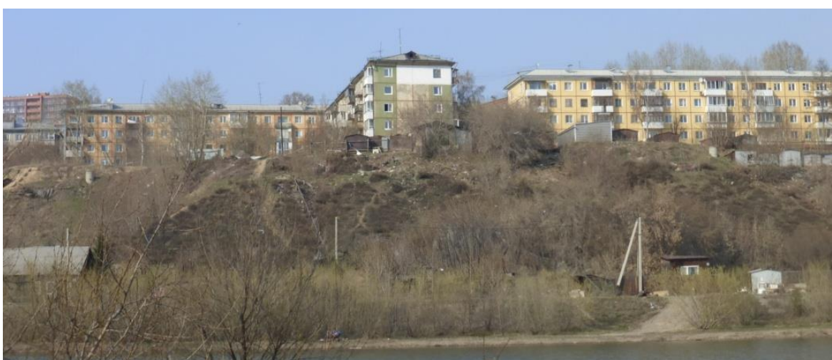
Рис. 41. Общий вид застройки жилыми домами серии 1-335с на участке № 2
