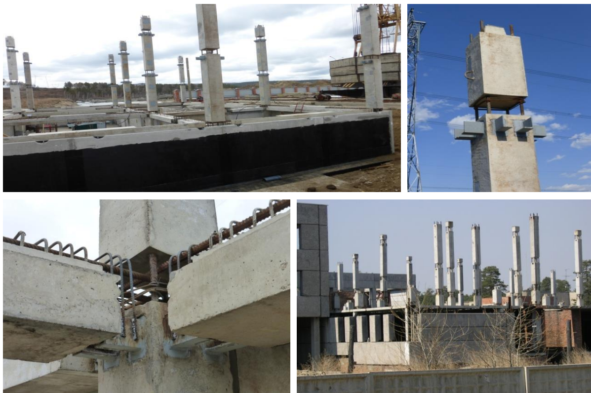
Рис. 18. Монтаж конструкций каркаса с «разрывом сборного бетона» в городах Шелехове и Ангарске Иркутской области
