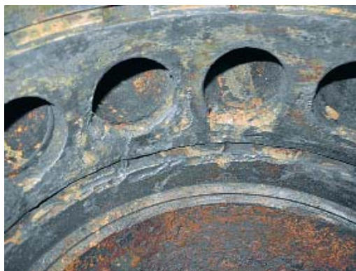
Рис. 14. Характер коррозионного разрушения ПСМ АГЗУ
