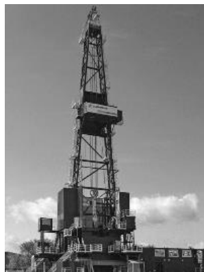
Рис. 5.2. Буровая установка 4000/250 ЭК-БМЧ-2
