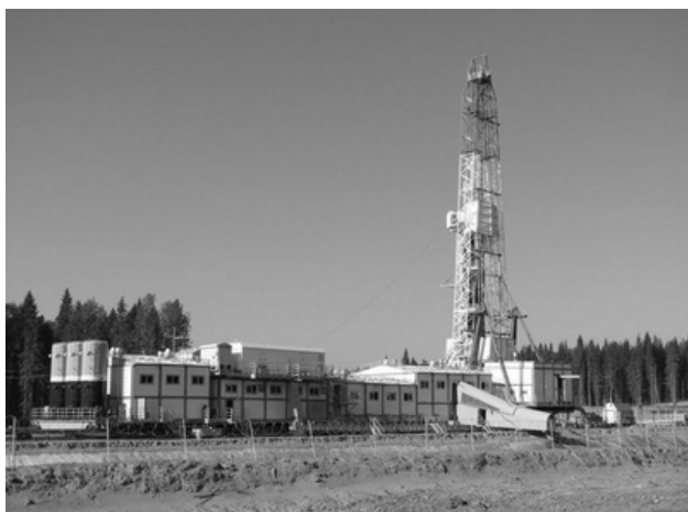
Рис. 3.4. Общий вид буровой установки
