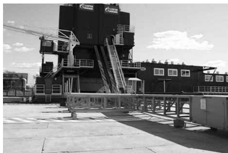
Рис. 5.9. Механизированный приемный мост
