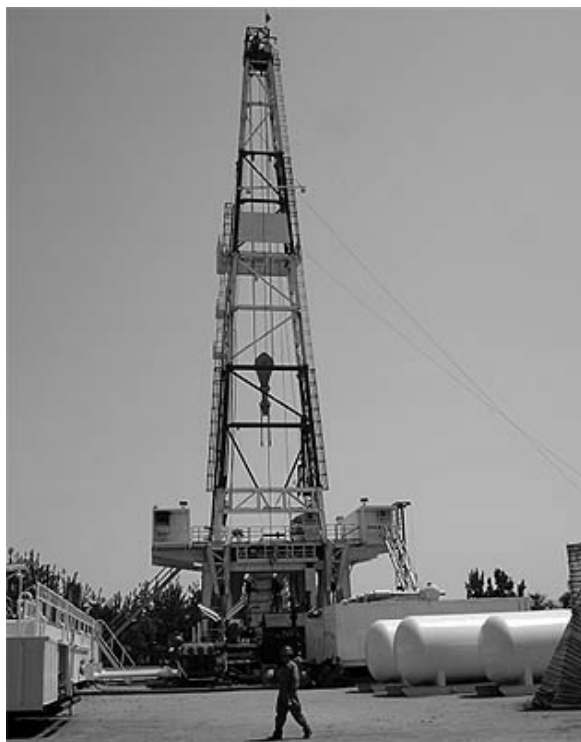
Рис. 7.1. Буровые установки, работающие в Туркменистане
